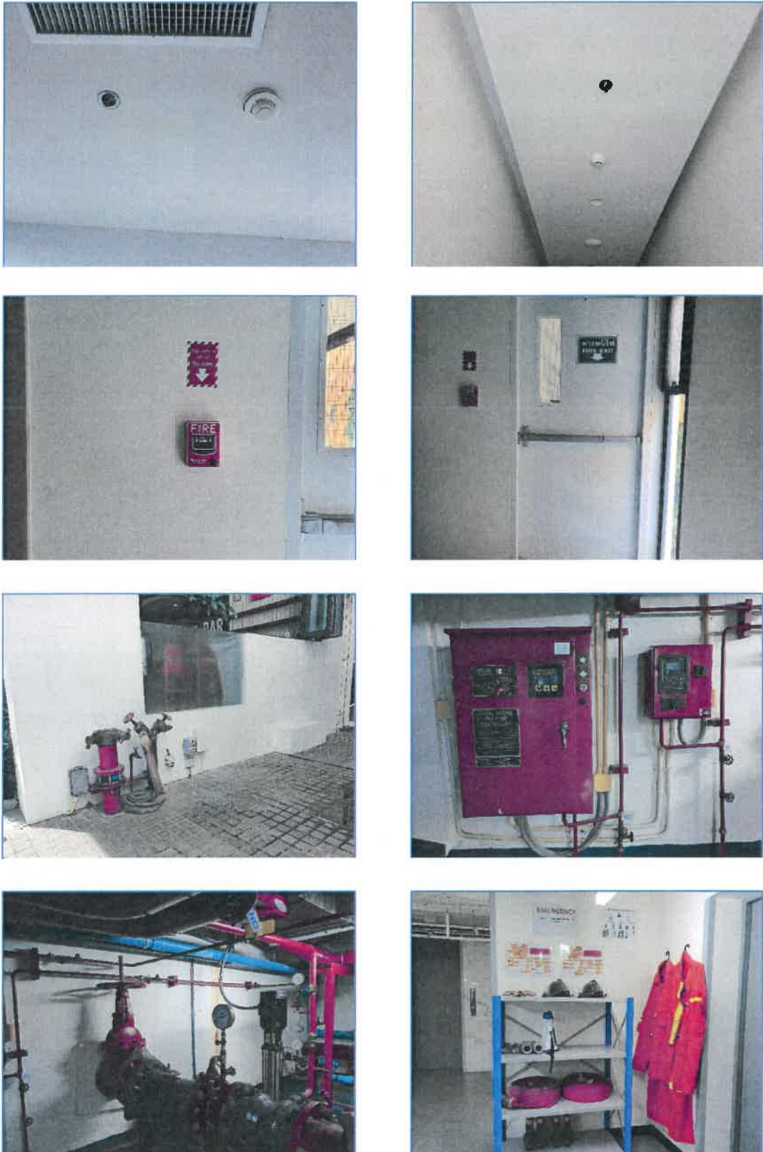
ภาพถ่ายที่ 2.2-20 ระบบแจ้งเตือนอัคคีภัยและป้องกันอัคคีภัยภายในโรงแรม
